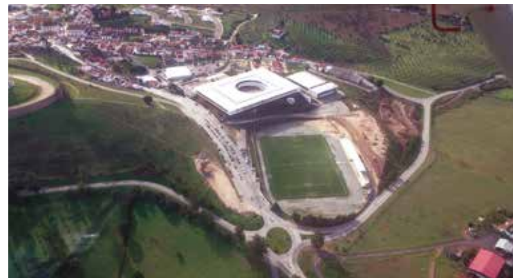
Escola Cunha Rivara, Arraiolos
