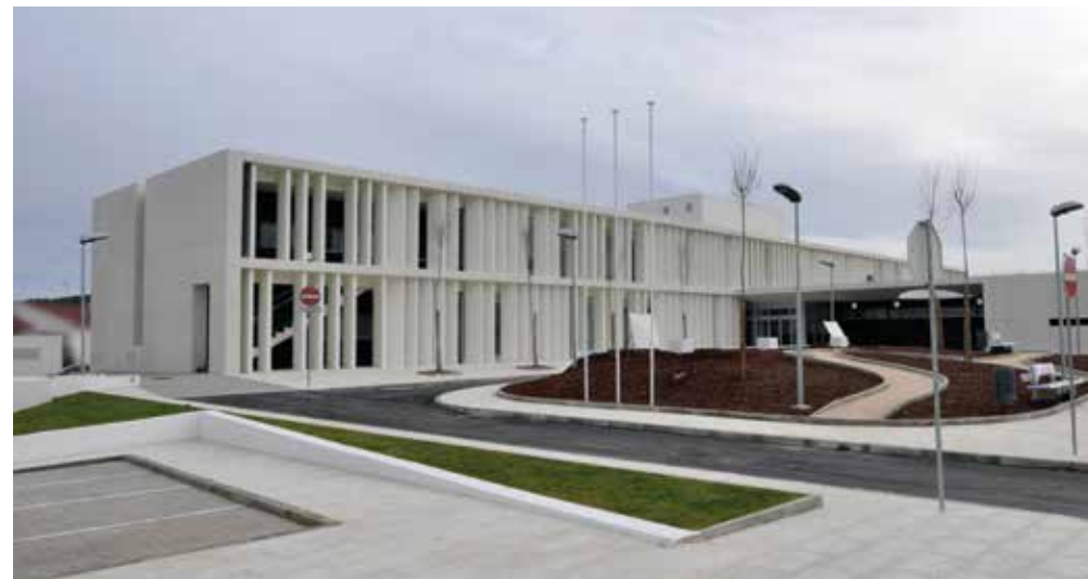
Centro de Saúde, Montemor o Novo, 2009
